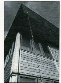
Houtskeldebouw met licht op de verdere afbouw.
